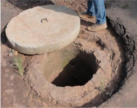
FIGURA 9: POÇO DE VISITA COM A SAÍDA OBSTRUÍDA.
